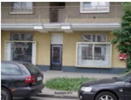
Widok siedziby Rady Osiedla przed remontem
