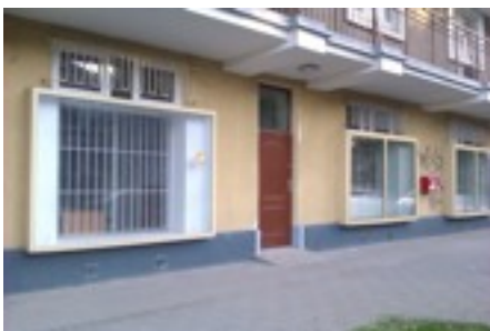
Widok siedziby Rady Osiedla po remoncie
