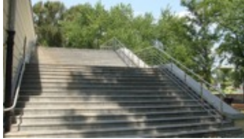
Schody nad kinem Muranów z prawą barierką zamkniętą na górze stwarzającą niebezpieczeństwo wypadnięcia np. dziecka
