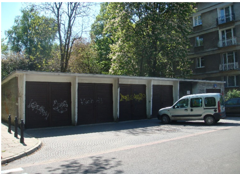
Widok pawilonu garażowego od ul. Miłej
